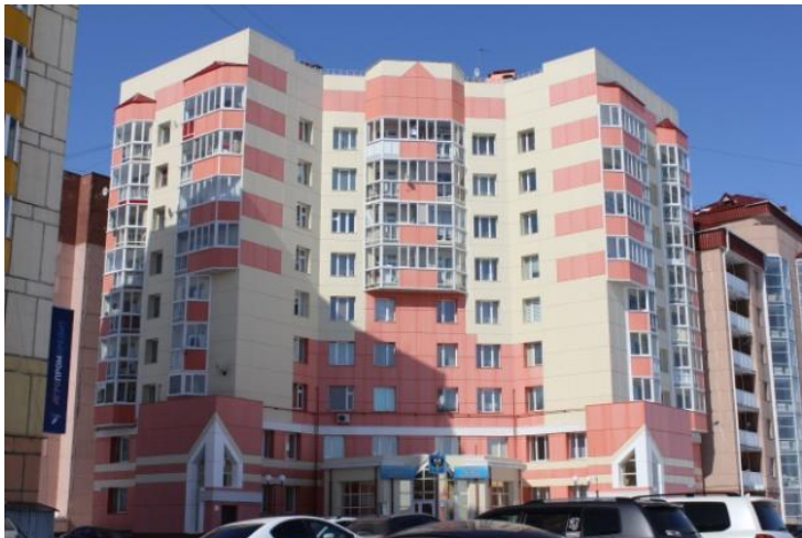
Жилой дом , ЯНАО, г.Новый Уренгой, мкр. Восточный д.2/3А
