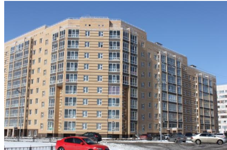
Жилой дом , ЯНАО, г.Новый Уренгой, мкр. Дружба д.5/1
