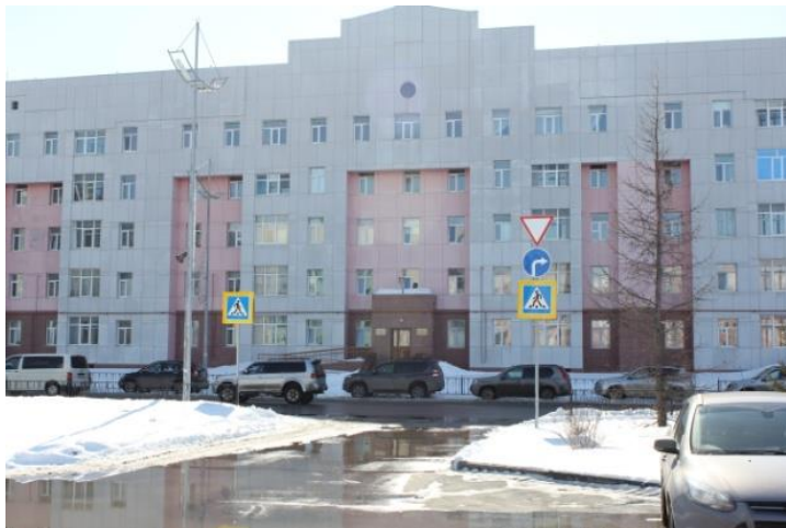
Жилой дом , ЯНАО, г.Новый Уренгой, мкр. Мирный д.1 корп.1
